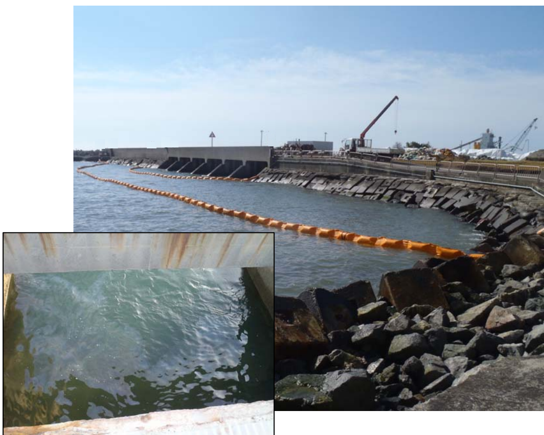
3, 4号機放水口付近 オイルフェンス設置状況
