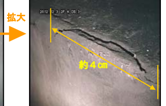
蒸気乾燥器支持ブラケット [拡大] 【撮影場所：原子炉内】 （平成24年12月3日撮影）
