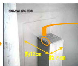
蒸気乾燥器支持ブラケット 【撮影場所：原子炉内】 （平成24年12月3日撮影）
