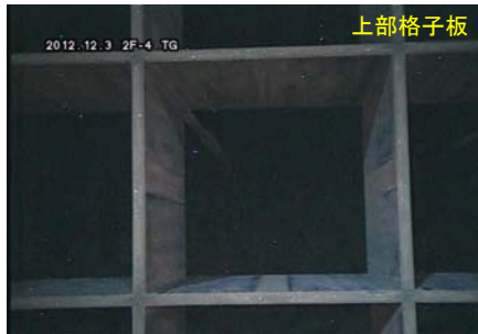
【撮影場所：原子炉内】 （平成24年12月3日撮影）
