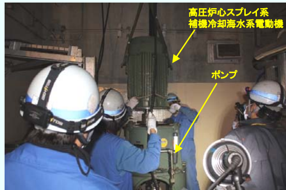
電動機据付作業の様子 【平成24年12月26日据付完了】 (平成24年12月26日撮影)
