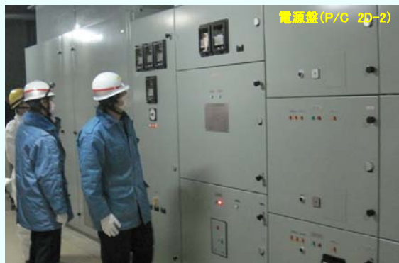
機能確認の様子 【平成24年12月25日本設化完了】 (平成24年12月25日撮影)
