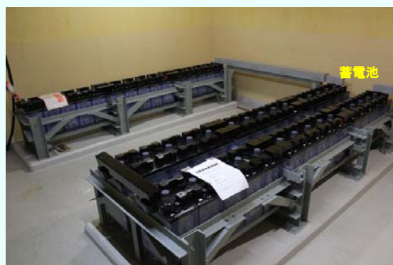
蓄電池据付完了の様子 【平成24年12月18日据付完了】 (平成24年12月25日撮影)
