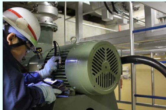
非常用ガス処理系(A)電動機 振動測定の様子 【平成24年12月14日本設化完了】 (平成24年12月14日撮影)
