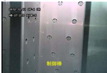
【撮影場所:原子炉内】 (平成24年12月11日撮影)
