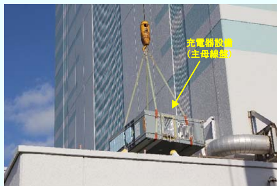
充電器設備(主母線盤)搬入の様子 (平成24年11月21日撮影)
