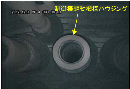
【撮影場所：原子炉内】 （平成24年12月3日撮影）
