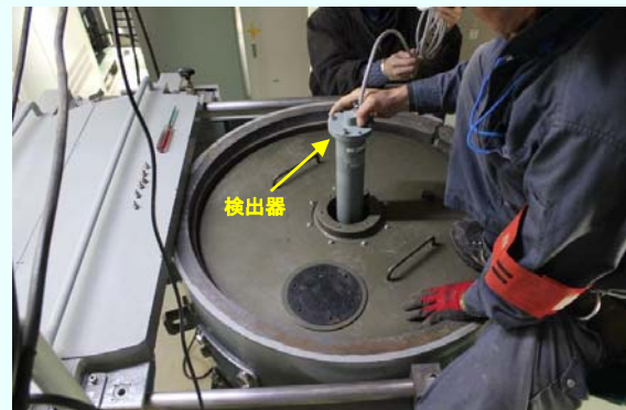
1・2号放水口モニタ(検出器)取付作業の様子 (平成24年12月18日撮影)
