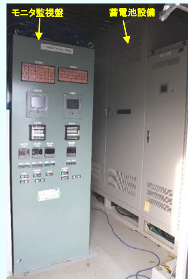
1・2号放水口モニタ監視盤等据付完了の様子 【平成24年12月10日据付完了】 (平成24年12月18日撮影)
