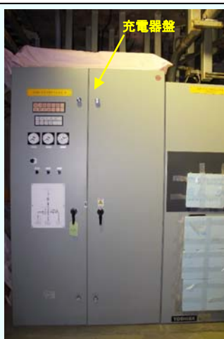
充電器盤据付完了の様子 【平成24年12月3日据付完了】 (平成24年12月25日撮影)
