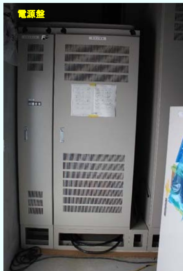
1・2号放水口電源盤据付完了の様子 (平成24年12月18日撮影)
