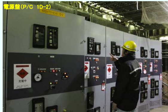
機能確認の様子 【平成24年12月27日本設化完了】 (平成24年12月27日撮影)
