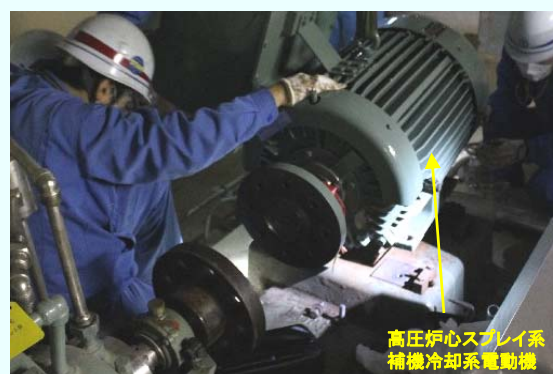
電動機据付作業の様子 【平成24年12月13日据付完了】 (平成24年12月13日撮影)
