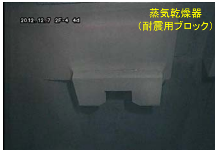
【撮影場所：仮置ピット内】 （平成24年12月7日撮影）
