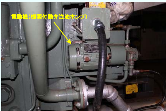
電動機(機関付動弁注油ポンプ※2) 据付完了の様子 (平成24年12月14日撮影)
