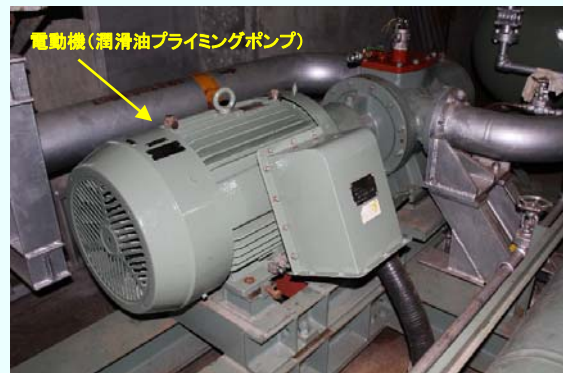
電動機(潤滑油プライミングポンプ※3)据付完了の様子 【平成24年12月12日据付完了】 (平成24年12月14日撮影)
