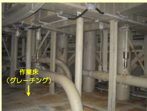
作業床 (グレーチング) ↓ 圧力抑制室内
