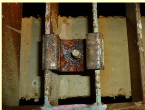
ナットがなかった箇所の留め金具
