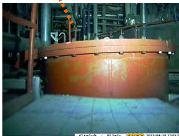
2号機トラス室内調査
