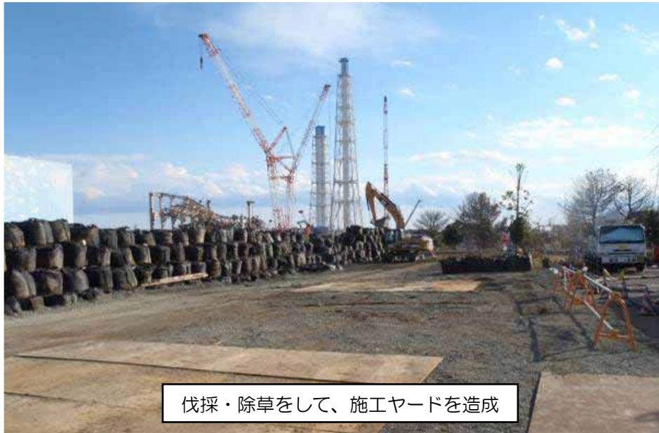
【施工ヤード状況】
