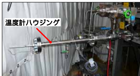
圧力容器温度計設置状況(H24/10/3)
