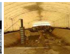
2 槽目の状況 (1/16撮影)
