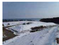
1 槽目の状況 (1/16撮影)
