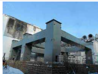
第1節部分鉄骨建方終了（1/14）
