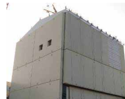
1号機原子炉建屋カバー設置
