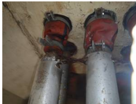
< 止水工事前の配管貫通部(ダクト側) > 平成24年7月2日 当社社員撮影
