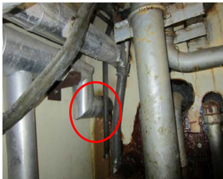
< 水流入箇所の配管貫通部(建屋側) > 平成24年5月29日 当社社員撮影
