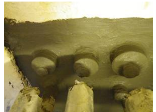
< 止水処理後の配管貫通部(ダクト側) > 平成24年12月19日 協力企業作業員撮影
