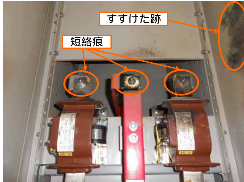
写真 短絡後の盤内
