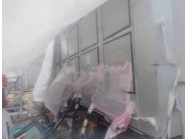
仮設3 / 4号M / Cの外観
