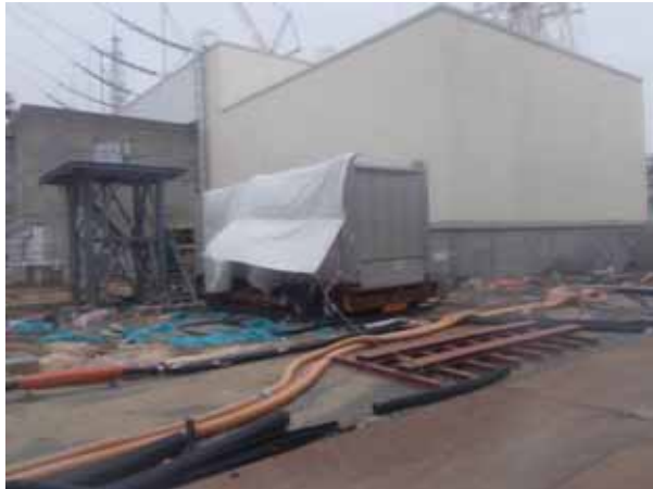
仮設3 / 4号M / C ( A ) 全景 ( 3 / 4号機開閉所 )
