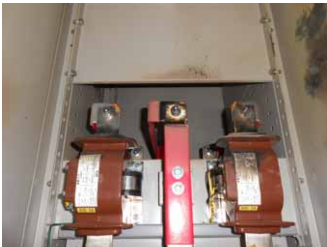
仮設3 / 4号M / Cの 計器用変流器 ( 端子 ) がすすけている状況
