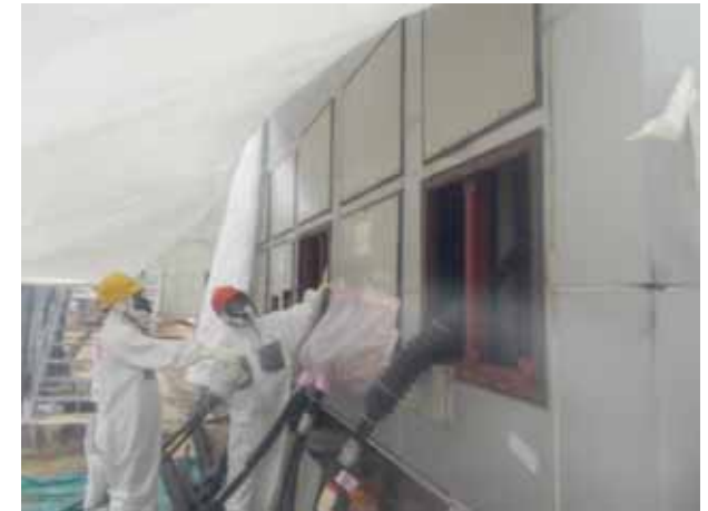
仮設3 / 4号M / C点検の状況
