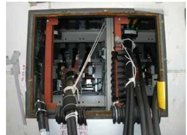
仮設3 / 4号M / C電源盤の扉を開けた状態 (すすけの確認された電源盤の下)
