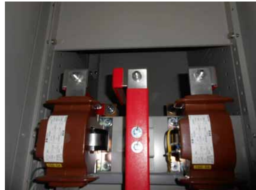
写真 健全な盤内
