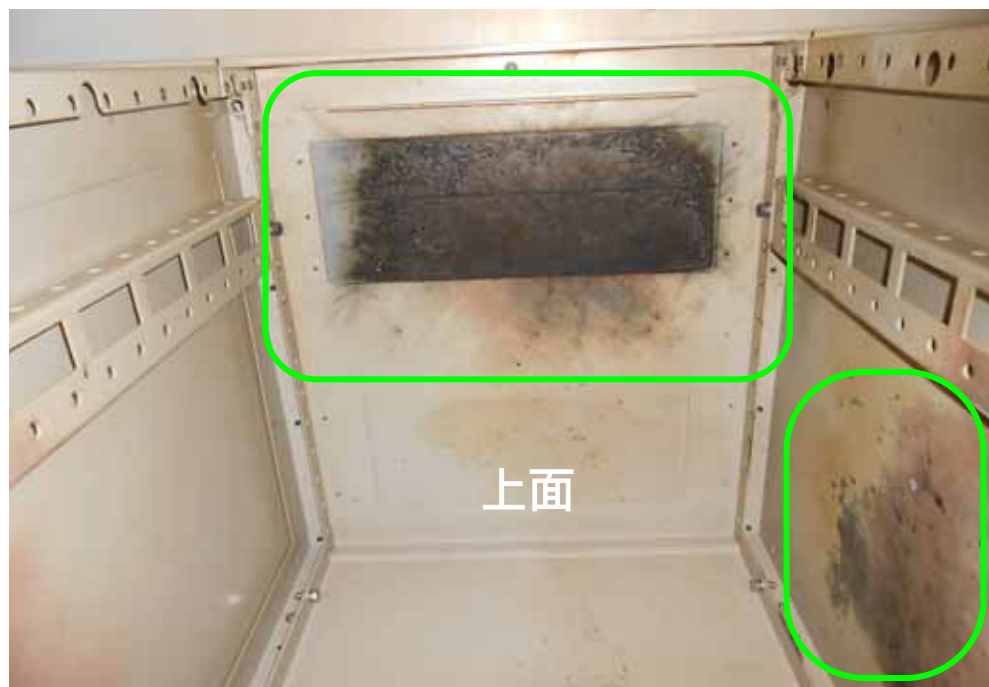
5 Aユニット上面の短絡痕の状況
