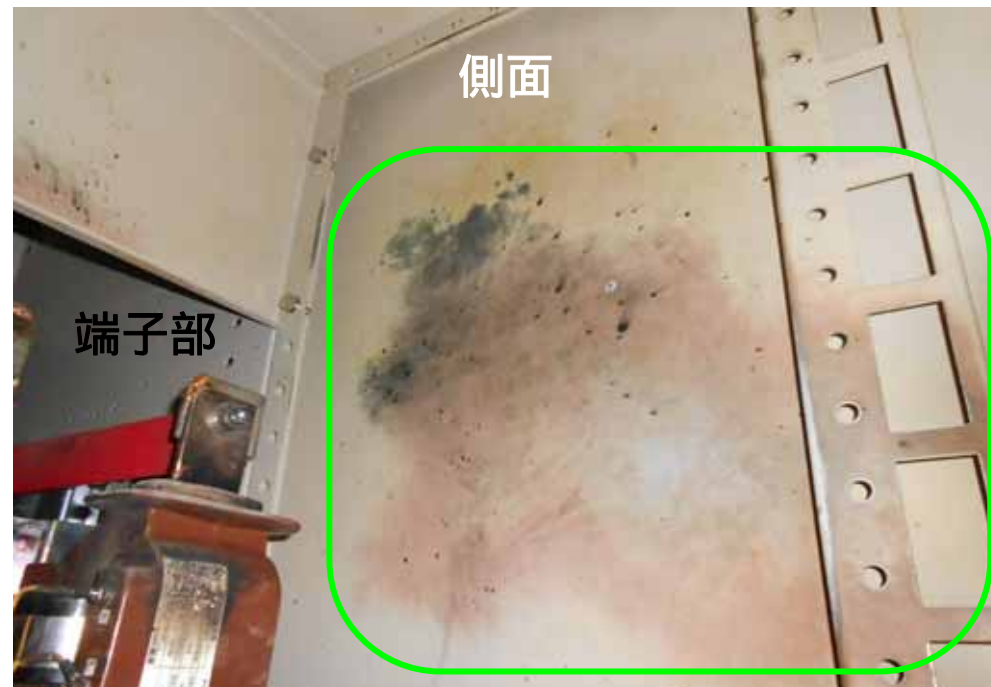
5 Aユニット側面の短絡痕の状況
