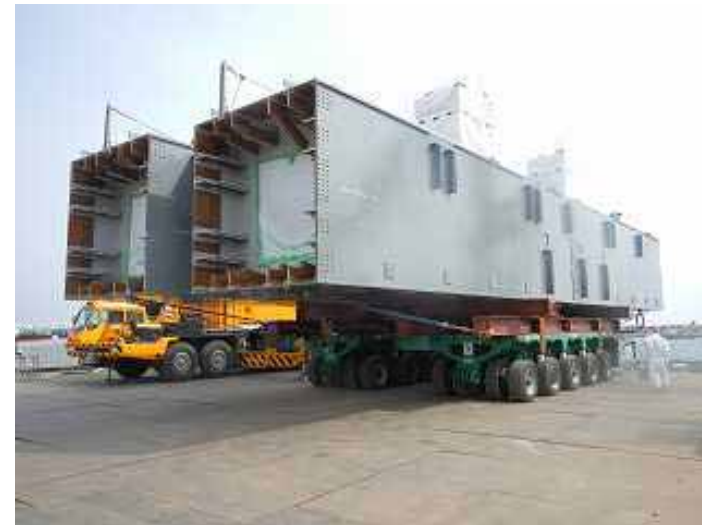
写真 鉄骨部材の構内運搬状況 特殊な輸送用車輜を用いて運搬
