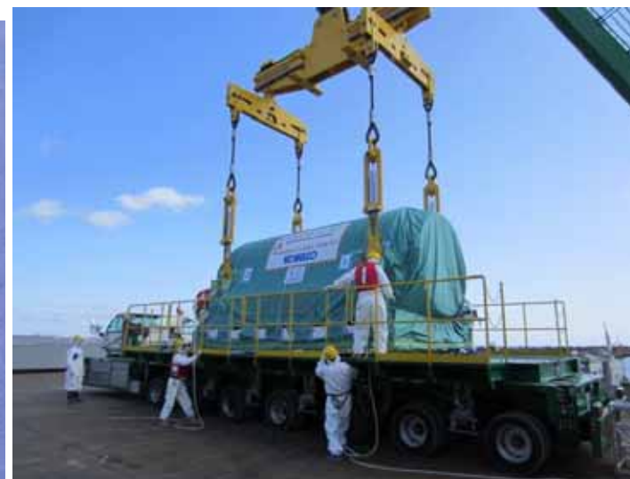
写真 乾式貯蔵キャスクの構内運搬状況
