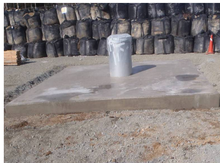
No.9揚水井（B系統）設置完了
