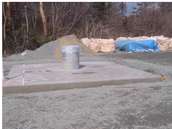
No.11揚水井（C系統）設置完了
