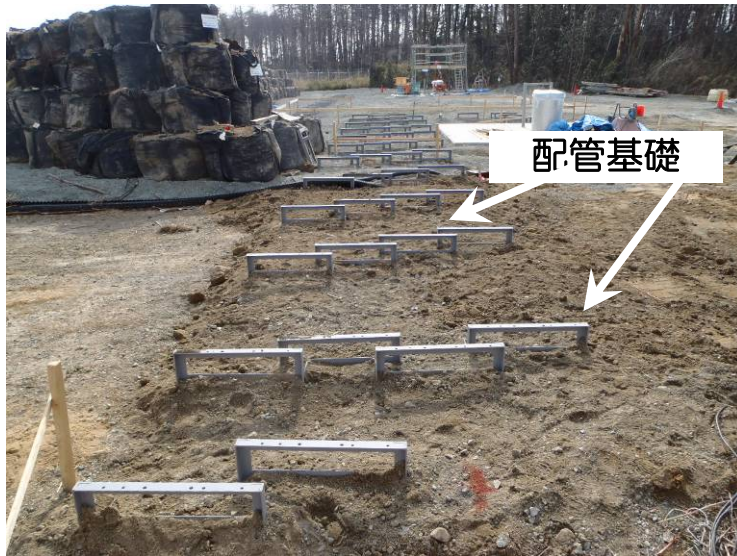
（B系統）配管基礎設置状況
