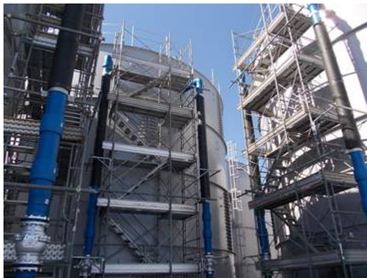
一時貯留タンク設置状況
