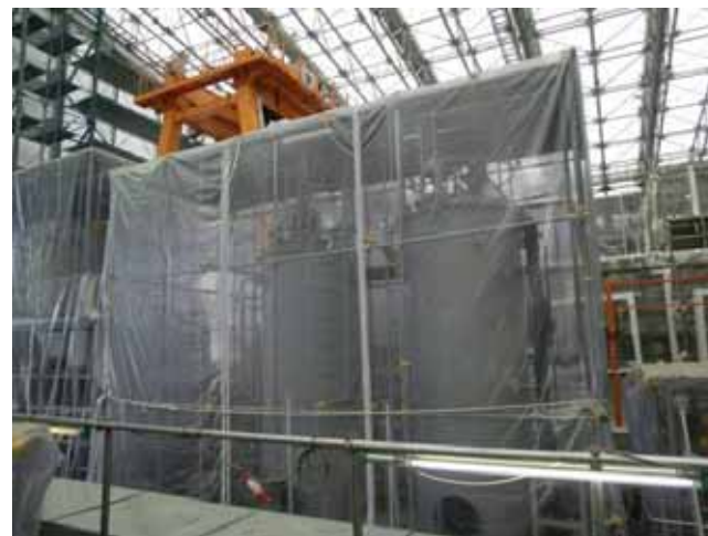
吸着塔（処理カラム） 平成25年3月27日撮影
