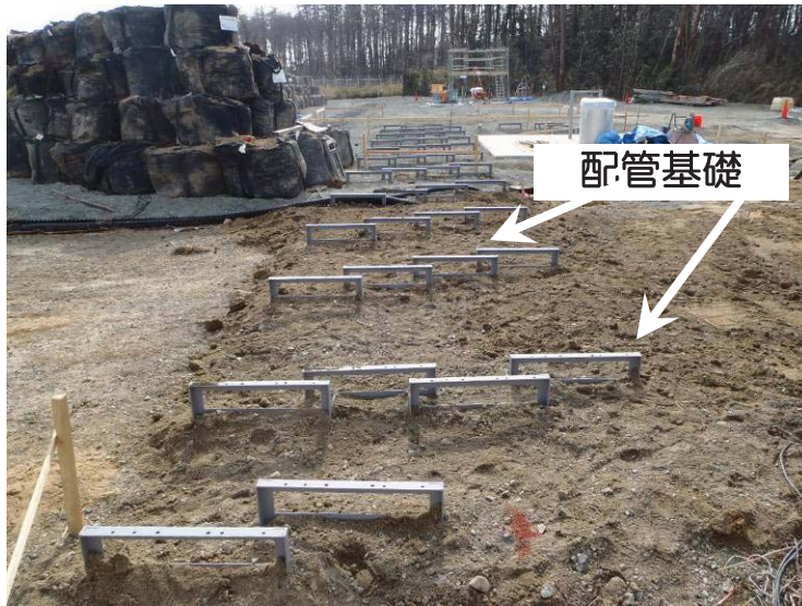
（B系統）配管基礎設置状況
