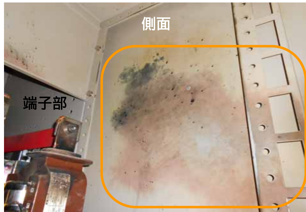
5 Aユニット側面のアーケ痕状況
