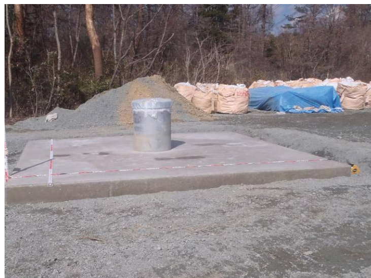
No.11揚水井（C系統）設置完了
