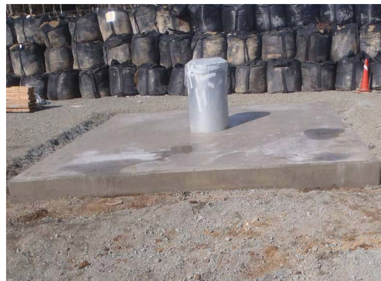
No.9揚水井（B系統）設置完了
