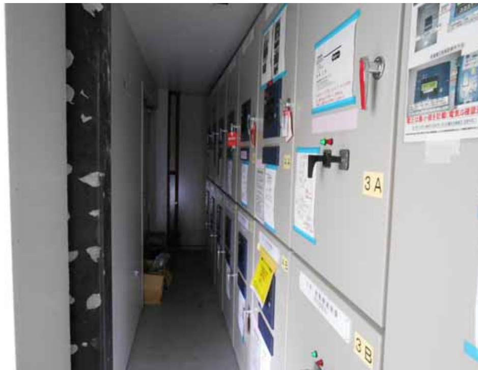
仮設 3 / 4号M / C 前面 (コンテナ内部)
