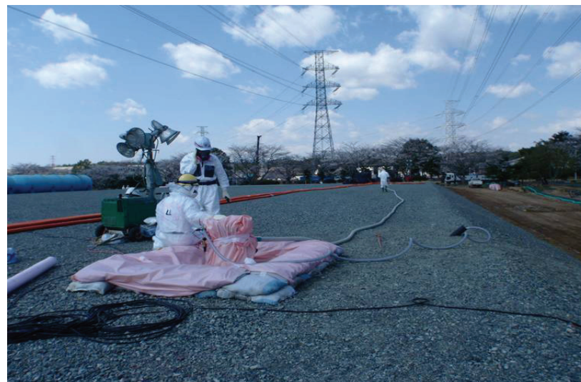
No. i 北東側拡散防止作業状況
