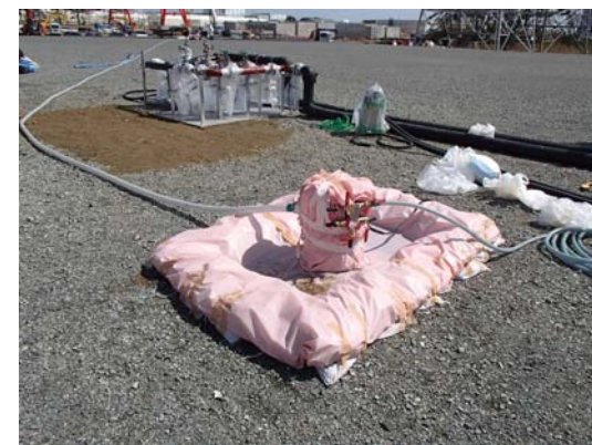
No.3貯水槽のポンプ設置状況(4/13撮影)
