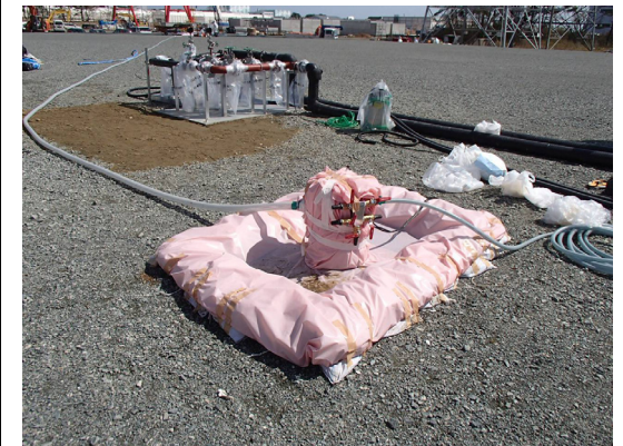
No.3貯水槽のポンプ設置状況(4/13撮影)
