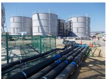
専用の配管・タンクを設置
