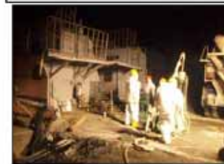
写真 2号機ピットA薬液注入時 (平成23年4月5日撮影)
