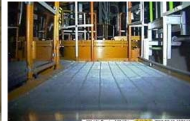
ロボットによるトラス室調査(H24/7/11)
