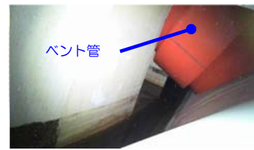
ベント管下部の撮影写真(H25/3/13撮影)
