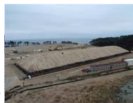
1 槽目の状況 (3/27撮影)
