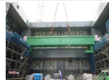
天井クレーンの設置 (6/7)
