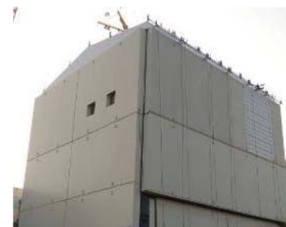
1号機原子炉建屋カバー設置
