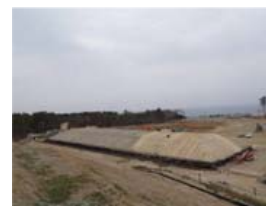
2 槽目の状況 (3/25撮影)
