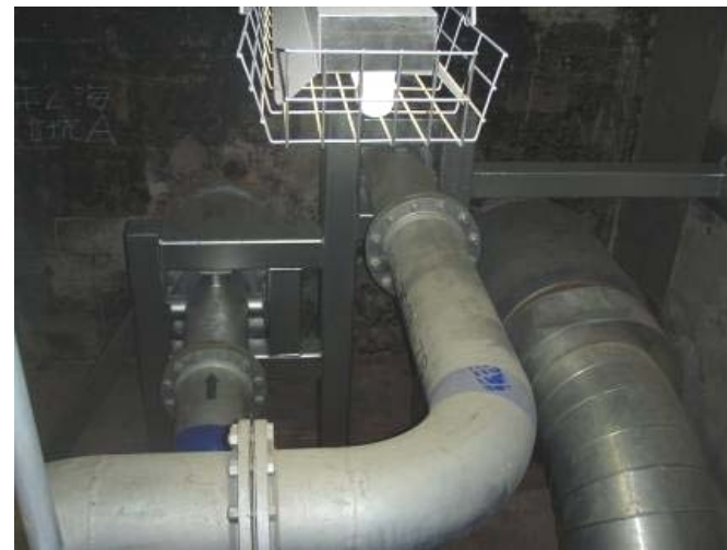
建屋接続部（奥：配管貫通部）
