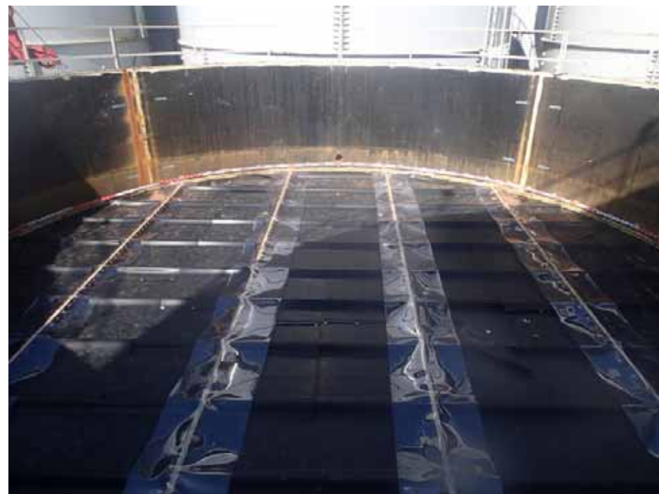
H 4 エリアNo.5 タンク 底板全景（養生後） （平成25年9月19日撮影）
