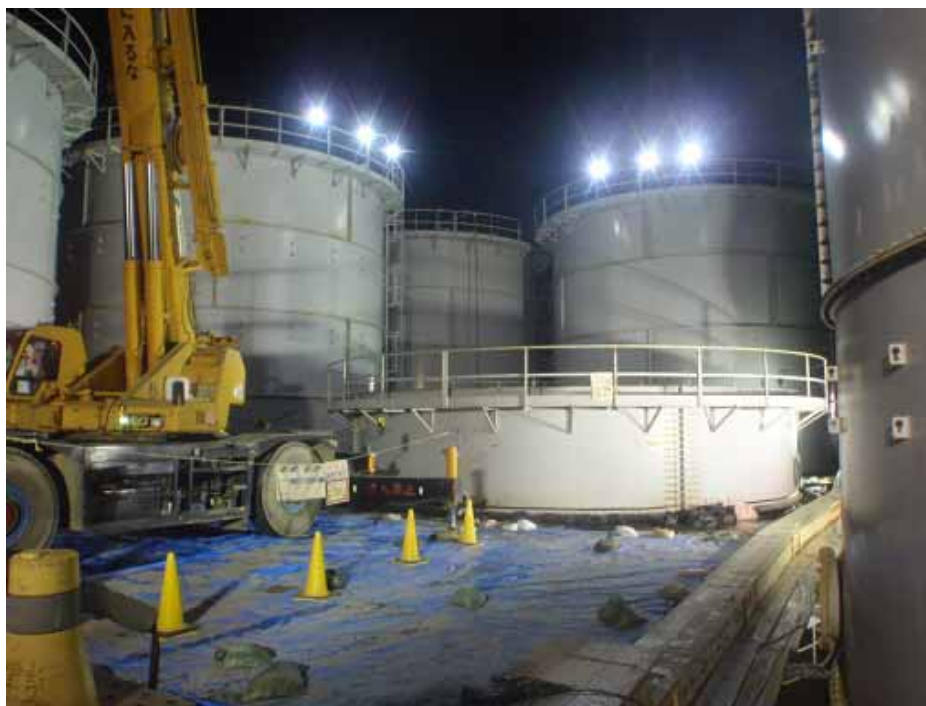
H 4 エリアNo.5 タンク 側板2段目撤去完了 （平成25年9月18日撮影）
