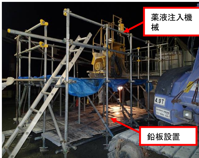
作業架台・鉛板設置状況
