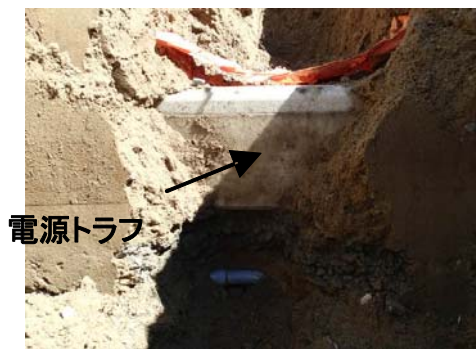
1号機スクリーンポンプ室北側護岸付近 電源トラフ
