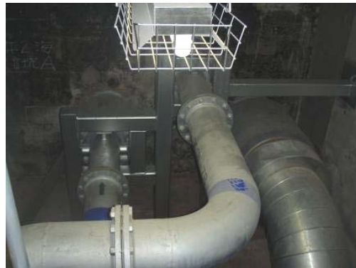
2号機立坑A 建屋接続箇所写真 (震災前)
