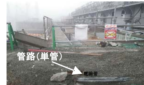
2号機スクリーンポンプ室付近管路
