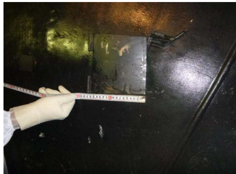
離脱せず当初の場所に残っていた 梯子用ゴムパッド (固定されていたテープを 取り外し、寸法測定を実施)
