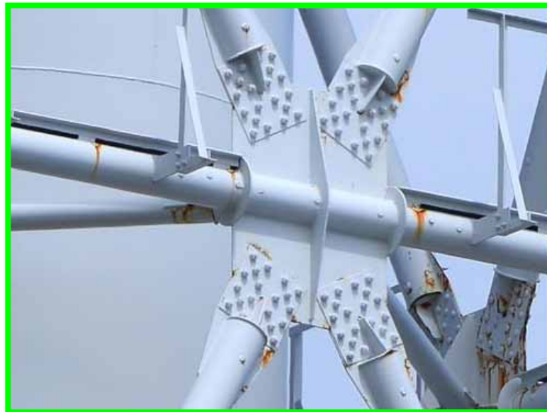
健全と判断した箇所の例
