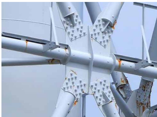
南側 (GL100m付近) 接合部
