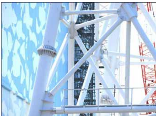
北側 (GL19 ~ 30m付近) 主柱・斜材
