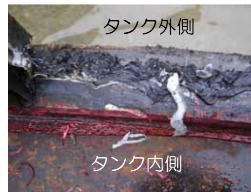
解体状況 (②付近底 板側)
