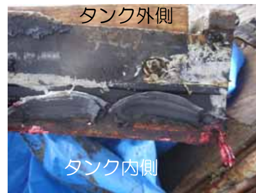
解体状況 (②付近側板側)
