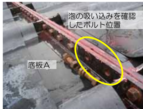
底板内面フランジ部PT剤塗布状況
