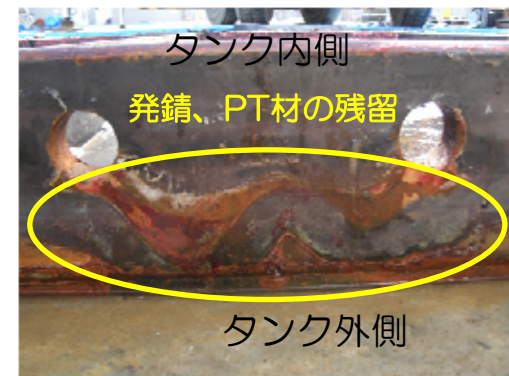
解体状況（底板A側）
