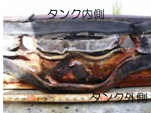
解体状況（底板B側）
