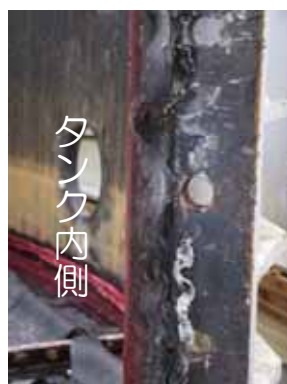
解体状況 (①付近側板)
