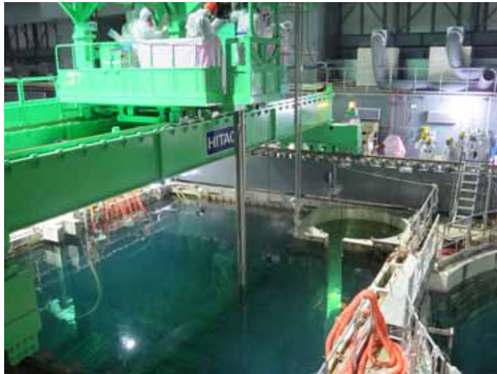
燃料取り出し作業（1）
