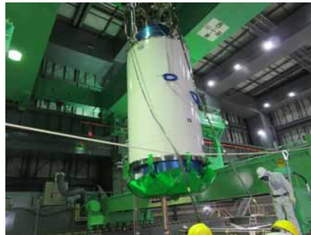
構内用輸送容器の吊り上げ（２）
