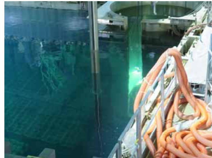
燃料取り出し作業（2）
