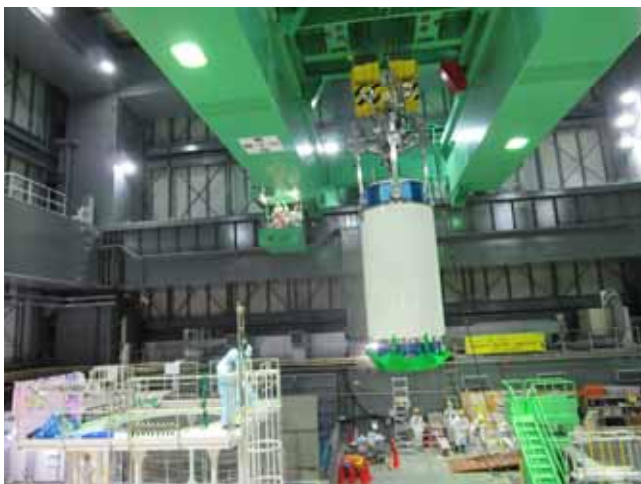
構内用輸送容器の吊り上げ（１）
