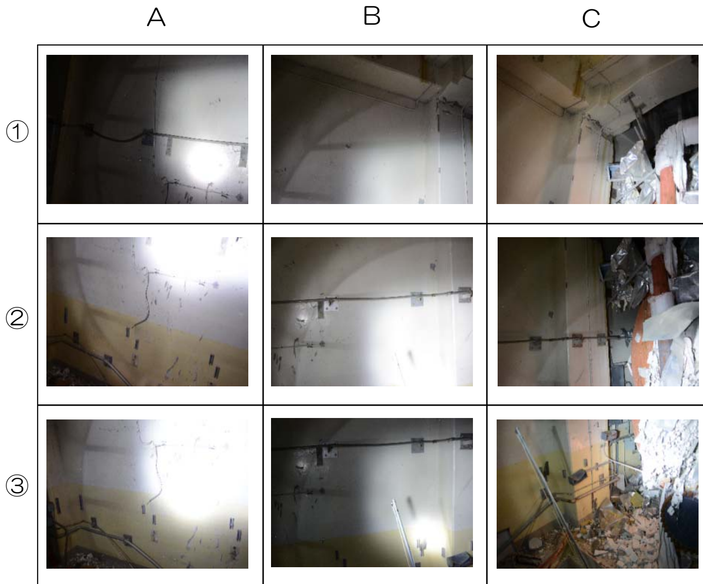
【4階 機器ハッチ 西側壁面】
