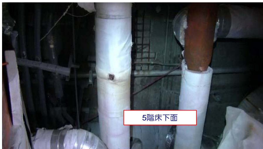
写真①：4階 天井(1)
