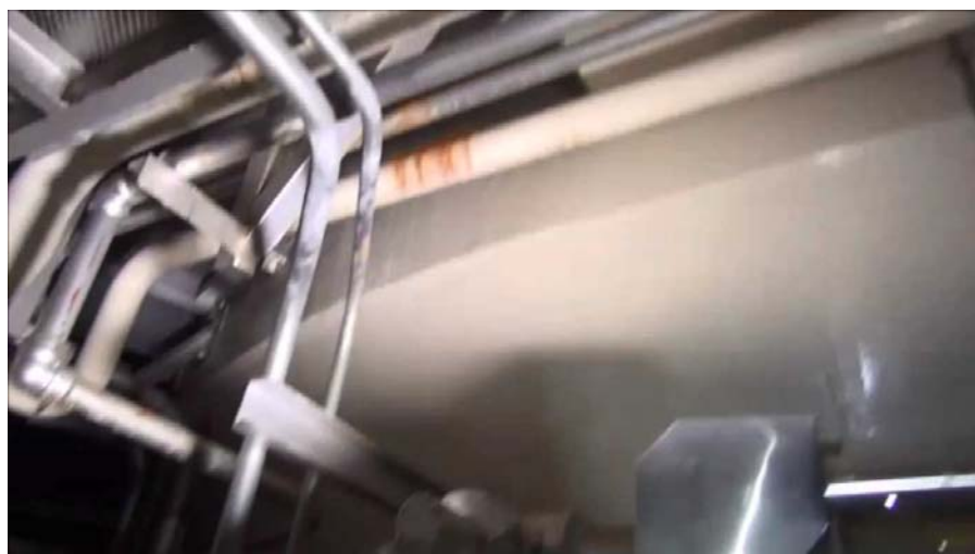
写真③：3階 シェル壁上部
