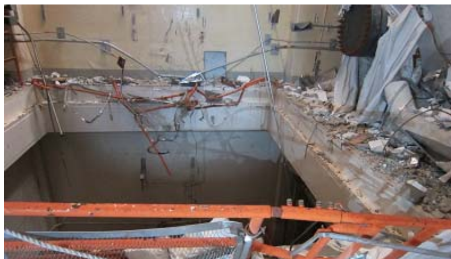
写真③：4階 西側外壁
