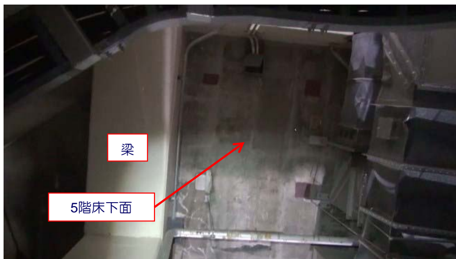
写真③：4階 天井(3)
