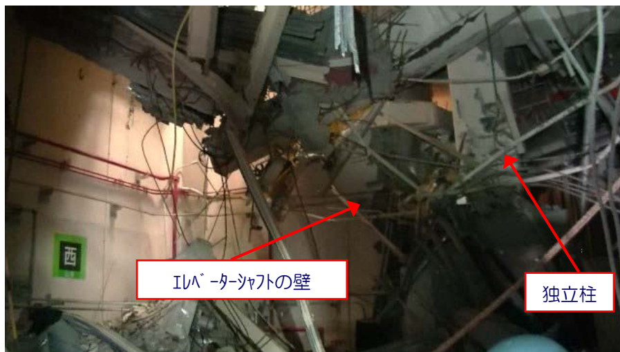
写真①：4階 北西側外壁
