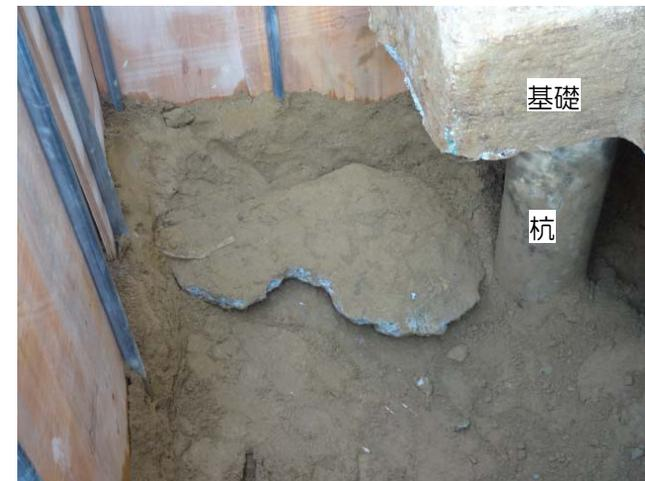
土砂と共に崩落した均しコンクリート
