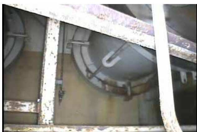
主蒸気配管B
