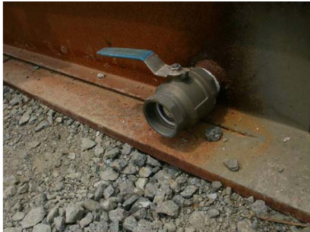
排水弁の状況
