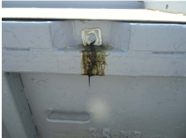
漏えい箇所 (No1-3)
