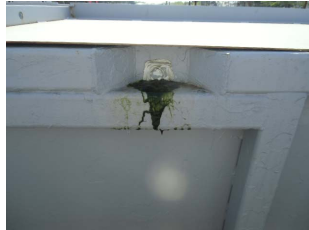
漏えい箇所 (No1-5)
