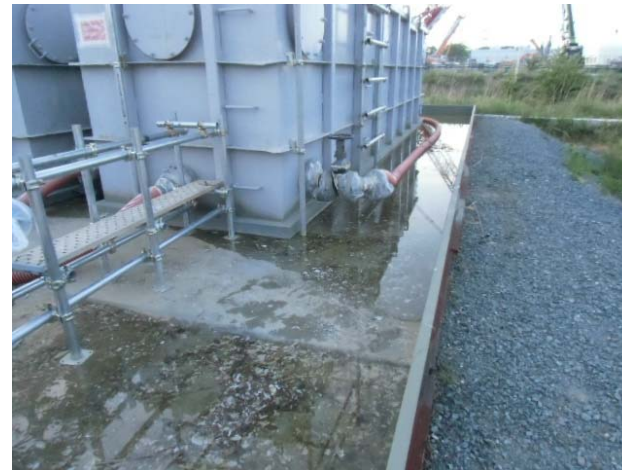
ノッチタンク堰内の状況
