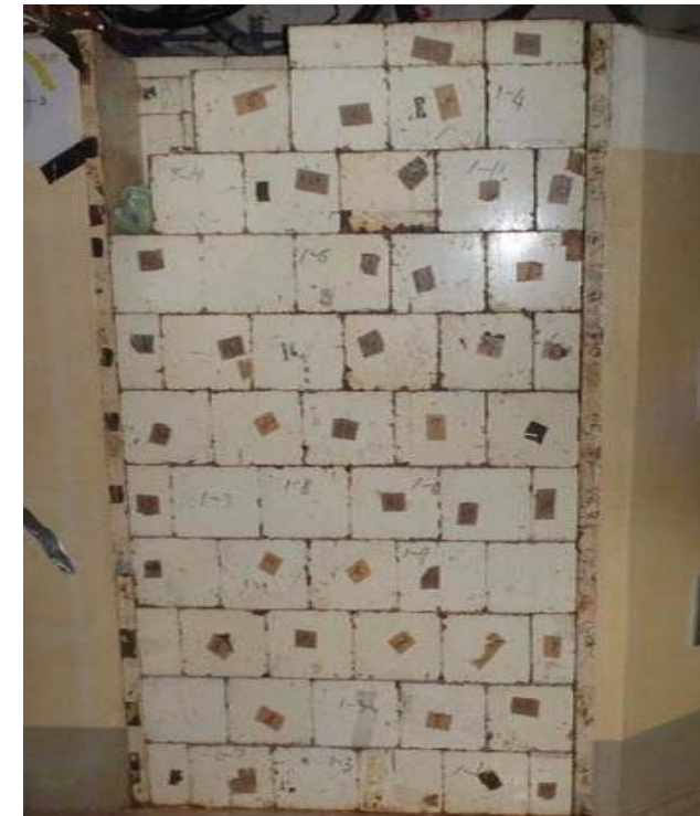
撤去前 遮へいブロック全体
