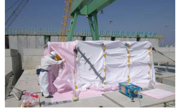
保管用ボックスカルバート上に設営中の簡易水抜き装置用ハウス
