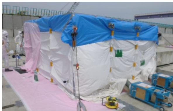
作業ハウス全景
