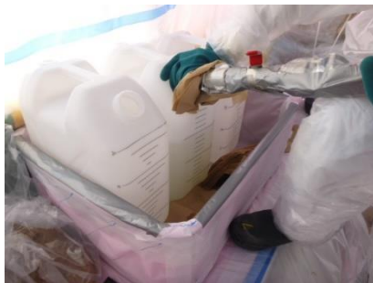
回収用タンク
