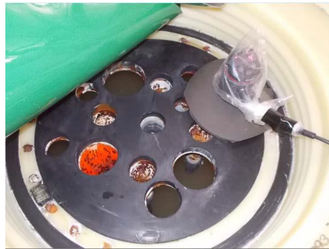
液位計による液位観察状況
