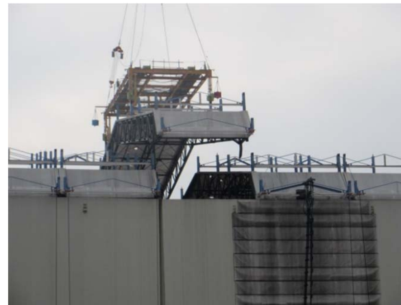
1号機建屋山側より撮影
