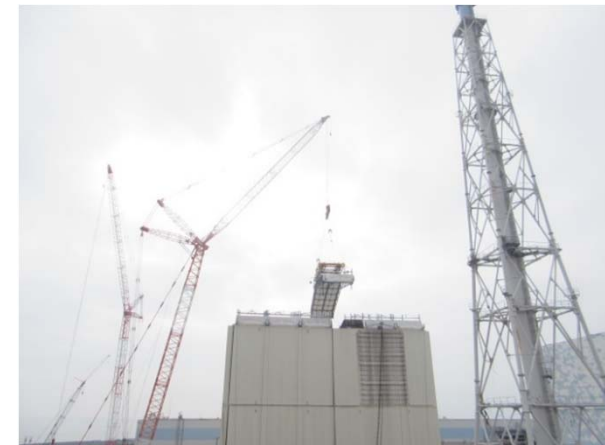
1号機建屋山側より撮影
