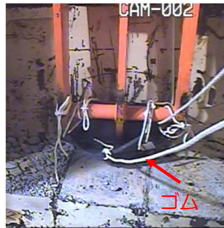
背面鉄板引抜状況
