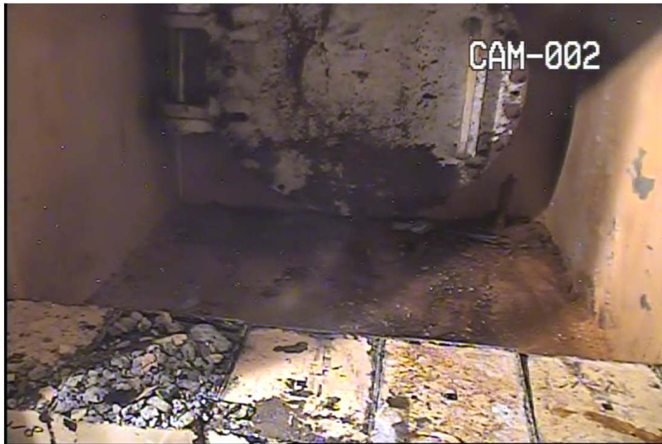
ブロック撤去前の状況
