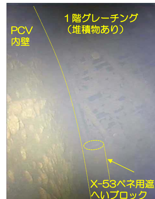
③1階グレーチング
