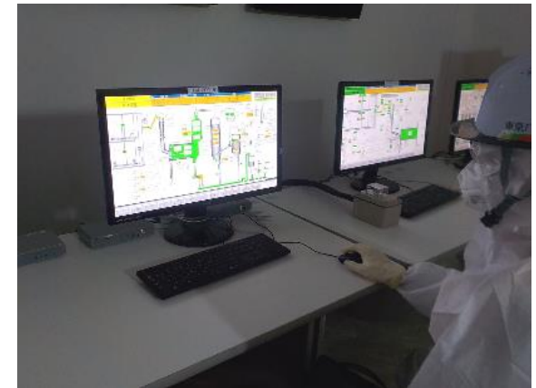
制御室 試験作業状況
