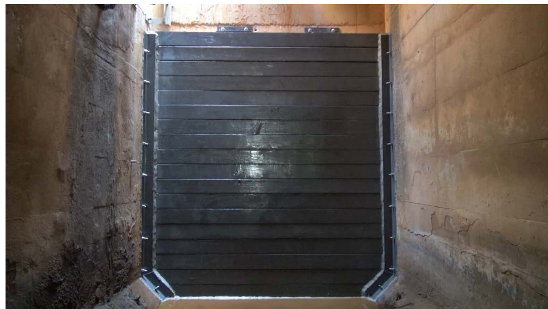
②旧K排水路止水状況
