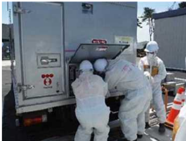
電源車運転操作訓練
