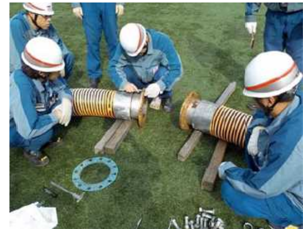
仮設ホース接続訓練
