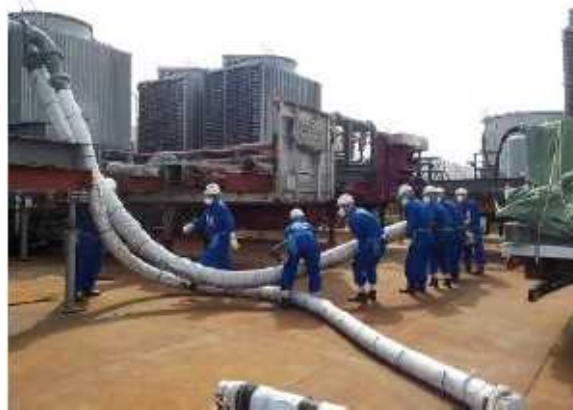
使用済燃料プール注水設備接続訓練
