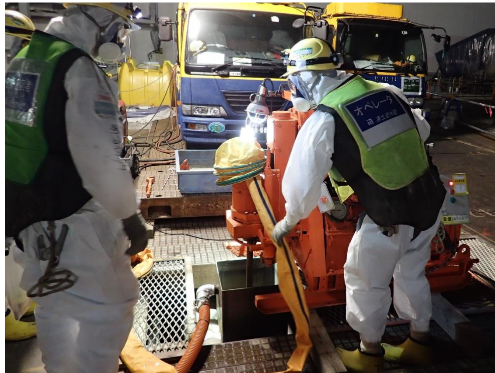
< 4号機南側注入作業の様子 >
