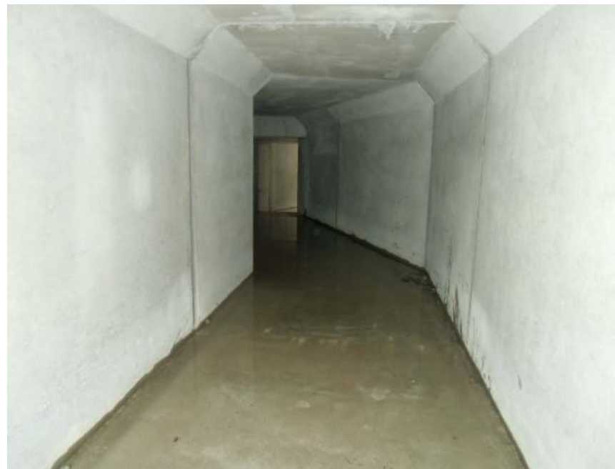
G1タンクエリア側溝内部状況
