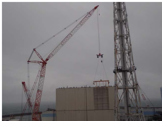
吊り上げ前（全景）
