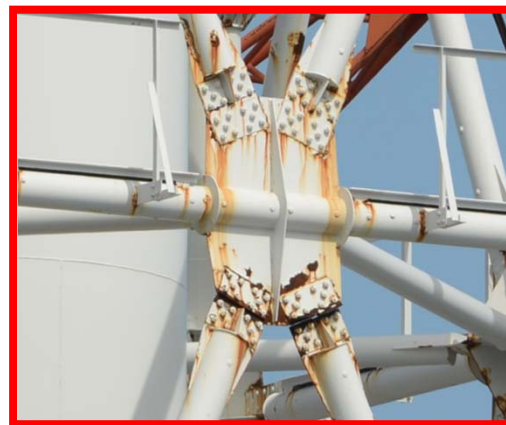
損傷した部材の状況 (2016.9)
