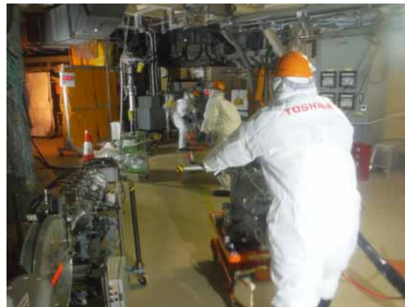
【2号機原子炉建屋内】
