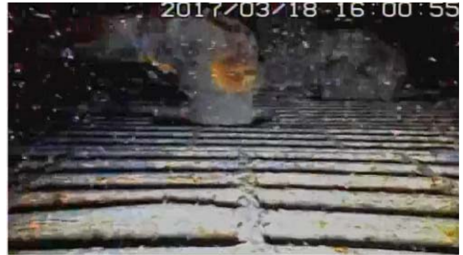
グレーチング上（調査装置 正面左側カメラ画像）
