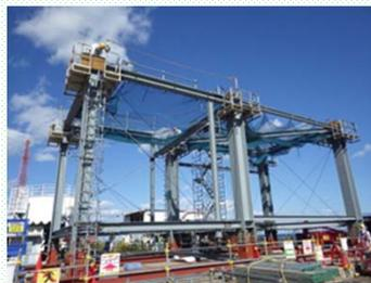
【時間】 遠隔操作型自動アンカー穴開け装置の採用
