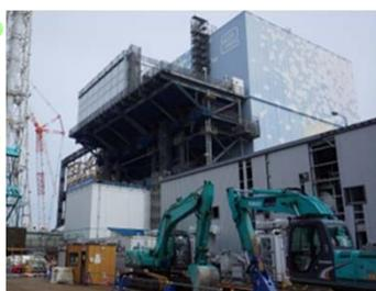
【時間】 アンカー穴開け用足場の鉄骨ユニットへの取付
