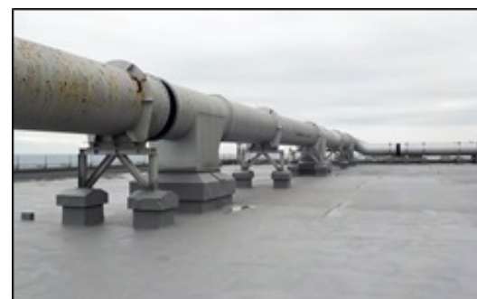
【現況】4号機T/B屋上（本設防水完了）
