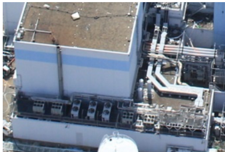
1号機T/B下屋の状況
