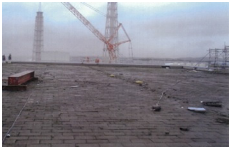
2号R/B屋上の状況
