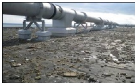
【施工前】4号機T/B屋上
