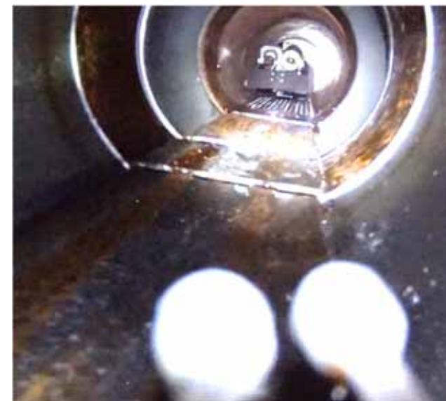
サンプル回収時の配管内の状況
