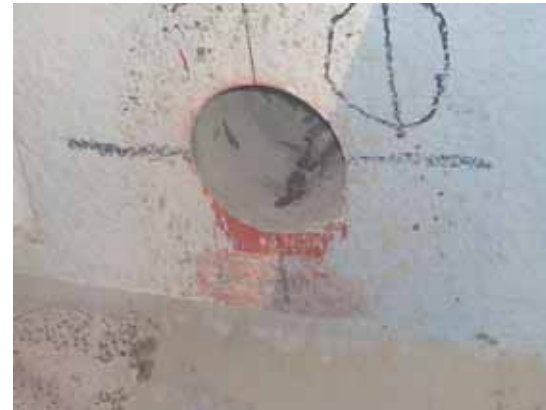
調査用コア削孔箇所の状況 2018年4月16日撮影
