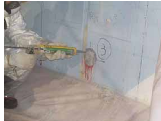
調査用コア削孔箇所の孔塞ぎ状況 2018年4月16日撮影
