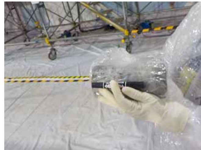
調査用コア採取状況
