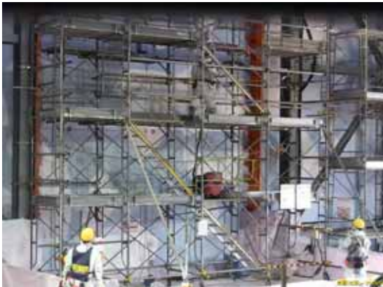
コア削孔箇所の作業状況（全景） 2018年4月16日撮影
