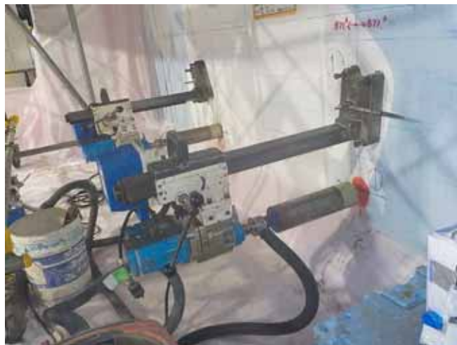
コア削孔装置設置状況
