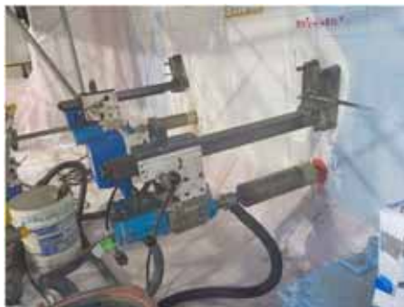
コア削孔装置設置状況
