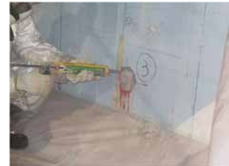
削孔箇所の孔塞ぎの状況
