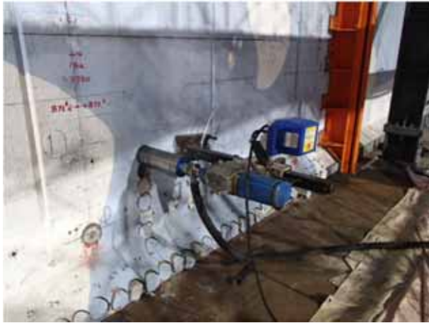
解体用コア削孔 (STEP3) 2018/4/24撮影
