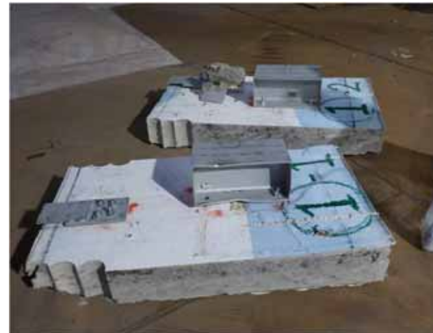
壁解体 (STEP6) 2018/5/28撮影
