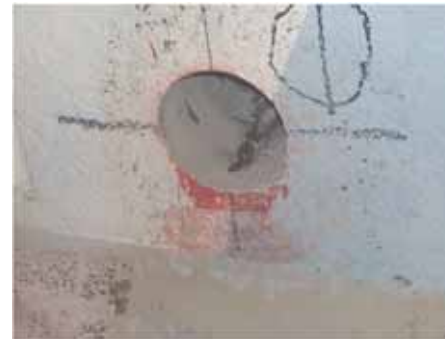
コアを削孔した状況
