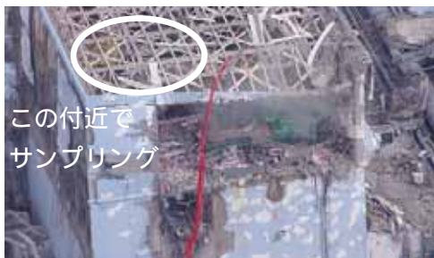
福島第一原子力発電所 4号機（南西角側）
