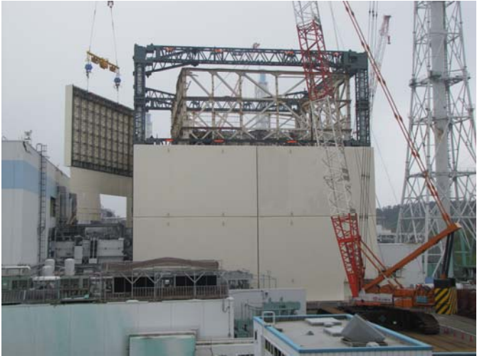
② 1号機原子炉建屋カバー設置状況 ～1号機北側から撮影～ 平成23年9月15日 当社社員撮影
