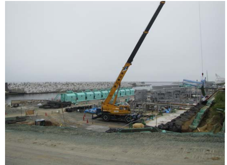
⑫ 5、6号機海側法面の補修作業 (土嚢を積む作業) ～6号機海側ヤードから撮影～ 平成23年9月15日 当社社員撮影
