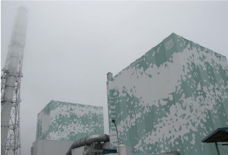
⑪ 5、6号機原子炉建屋外観 ～5号機原子炉建屋南西側から撮影～ 平成23年9月15日 当社社員撮影
