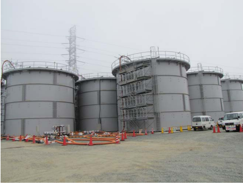
⑬ RO濃縮水貯蔵用タンク ～H1東エリアに設置～ 平成23年9月15日 当社社員撮影
