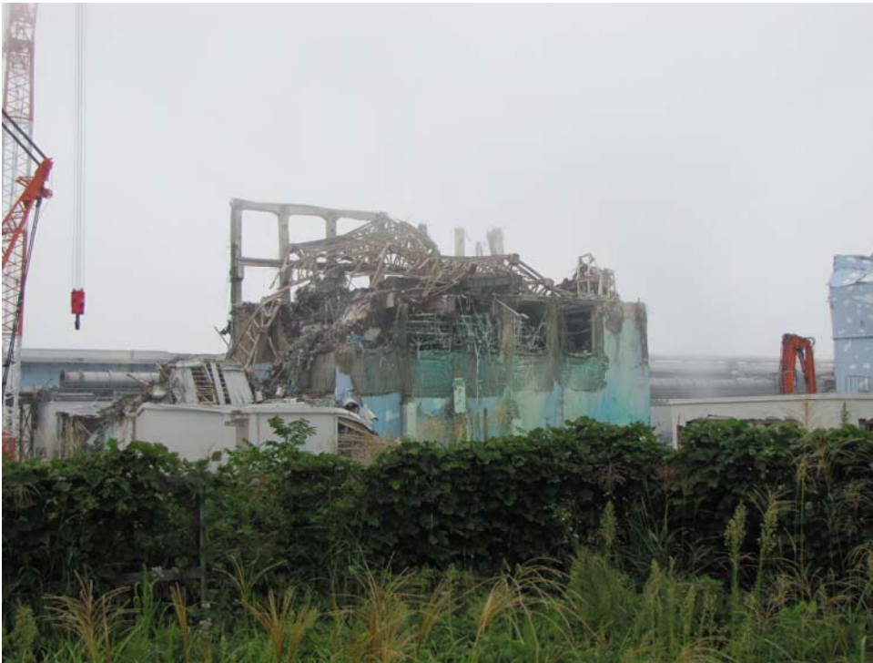
⑥ 3号機原子炉建屋外観 ～2・3号機間西側高台から撮影～ 平成23年9月15日 当社社員撮影
