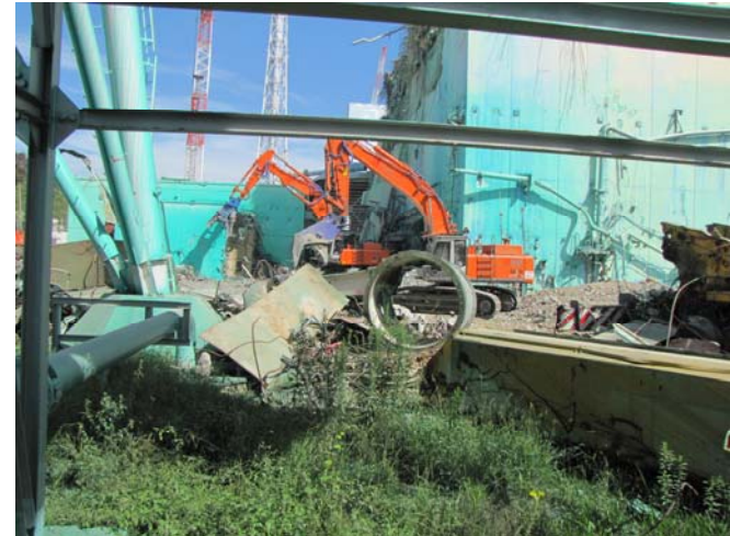
⑦ 3号機ガレキ撤去作業状況 ～原子炉建屋南西付近にて実施中～ 平成23年9月16日 当社社員撮影
