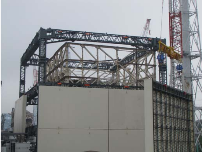
① 1号機原子炉建屋カバー設置状況 ～1号機北側から撮影～ 平成23年9月15日 当社社員撮影
