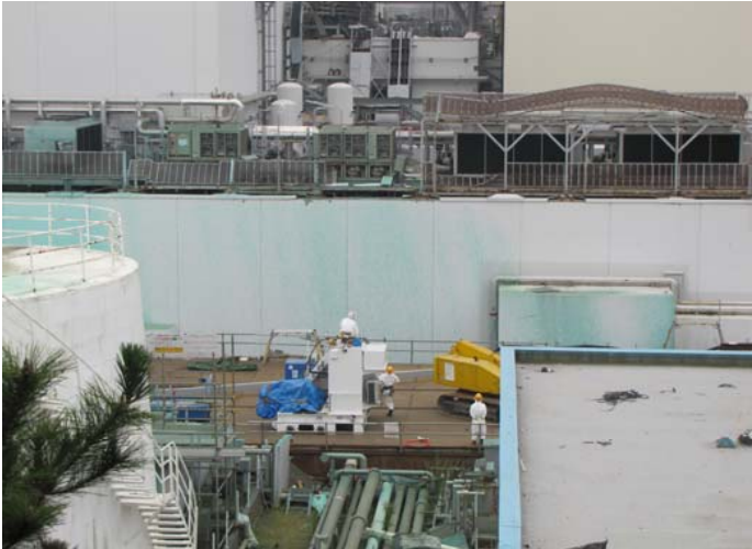
③ 1号機原子炉建屋カバー設置関連 大型クレーン操作風景 ～1号機原子炉建屋付近に操作機設置～ 平成23年9月15日 当社社員撮影
