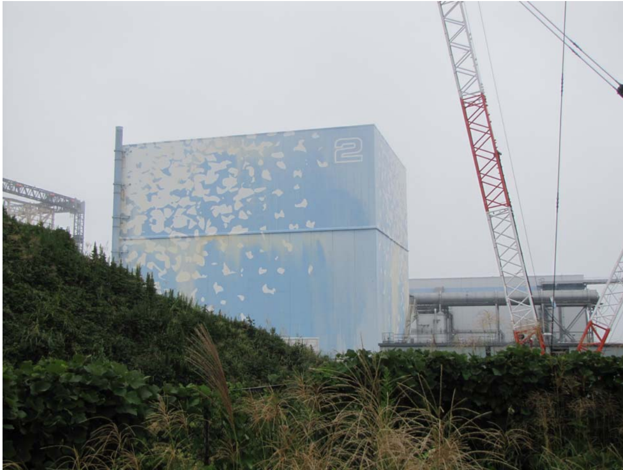
⑤ 2号機原子炉建屋外観 ～2・3号機間西側高台から撮影～ 平成23年9月15日 当社社員撮影
