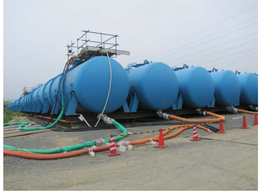
⑭ RO濃縮水貯蔵用タンク ～H1エリアに設置～ 平成23年9月15日 当社社員撮影
